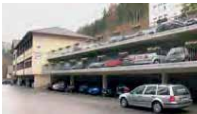
Erstes eigenes Gebäude der BFC: Adelbert-Moll-Haus in Calw
